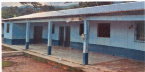
Foto 1: SE OBSERVA LAS COLOCACION DE COSTANERAS
