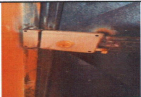
Foto 3: SE OBSERVA PUESTO LAS CHAPAS A LAS PUERTAS.
