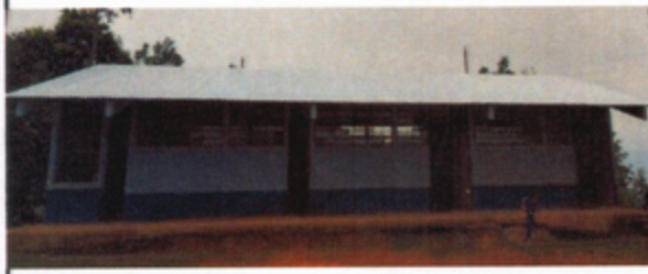
Foto 2: SE OBSERVA LA COLOCACIÓN DE LA ESTRUCTURA DE TECHO.
