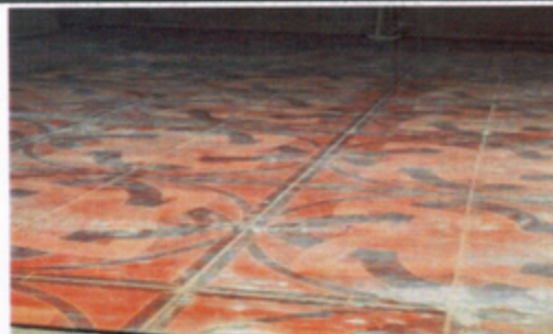
Foto 6: SE OBSERVA LA FINALIZACION DE AZULEJOS
